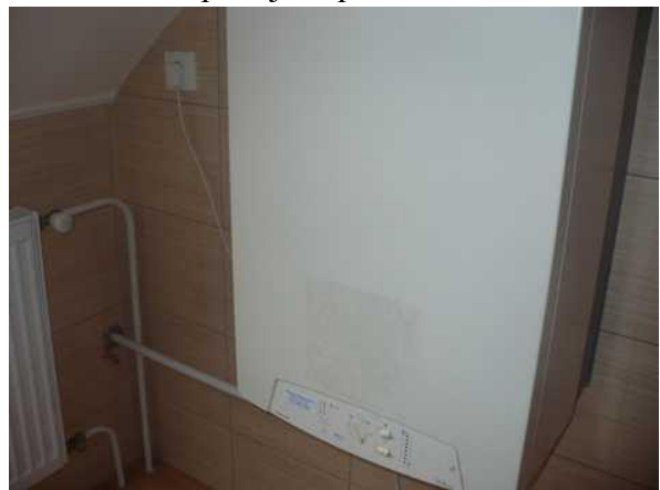
plynový kotel ÚT v koupelně podkroví
