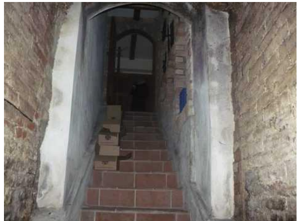
vstupní schodiště do sklepa
