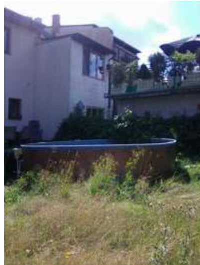
dtto, venkovní bazén poškozený
